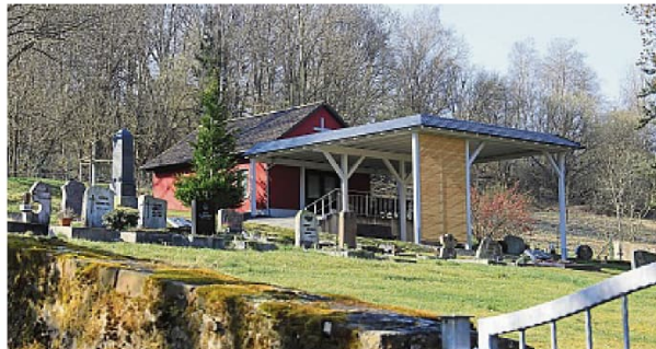
Auf dem Friedhof in Riedelbach finden künftig die Trauergäste Wetterschutz unter dem neuen Vordach. NEUGEBAUER
