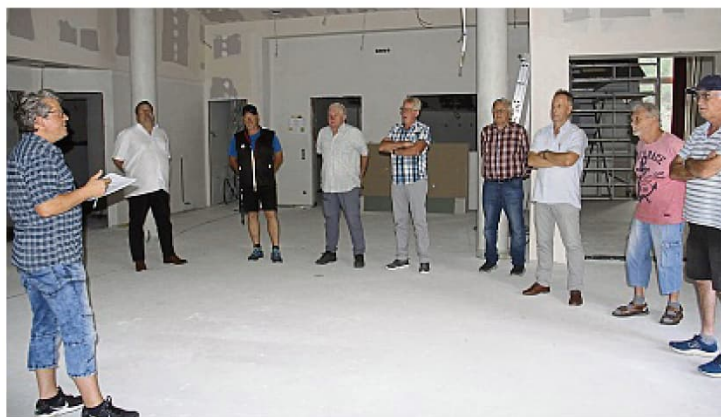
Ortsvorsteher Reimund Moses (links) stellt den Baufortschritt am Saalbau Felsenkeller vor.
