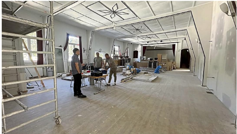
Der Trockenbau ist weitgehend fertig. Allerdings haben die Handwerker ziemlich viele Flecken auf dem Parkett hinterlassen. Das muss nun gesäubert werden.
