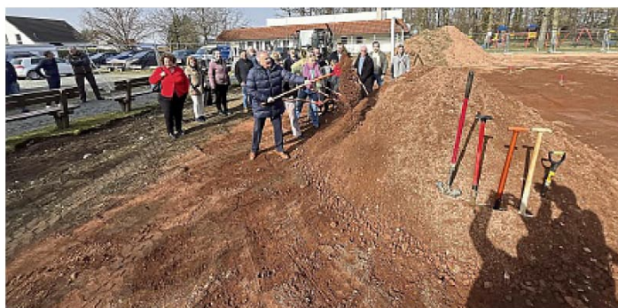
Startschuss mit Spatenstich beim Sport- und Gesundheitspark in Merzhausen: Bürgermeister Steffen Wernard (CDU, vorn) lud Politiker an die Schaufel ein. BURGER
