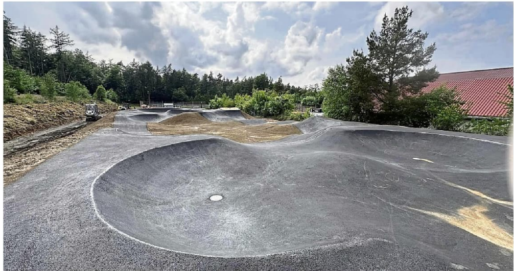
Auch der Pumptrack in Wehrheim (hier ein Bild der Bauarbeiten im Sommer des vergangenen Jahres) wurde über Leader mit 98920 Euro gefördert. Es können aber auch Vereine oder Privatleute Projekte fördern lassen. FRIEDRICH
